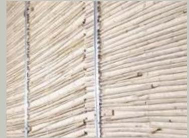
❷ Anbringen von Rohrgewebe St 70 als Putzträger direkt auf die esb-Plus Platten
