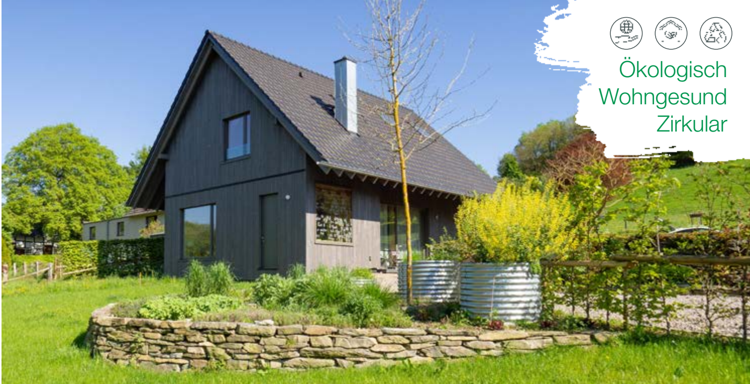
Einfamilienhaus in der Eifel, Holzständerbauweise mit esb-Plus Holzbauplatten und ClayTec Lehmputz im Innenausbau, Ausführung Zimmerei Krings Reinke
