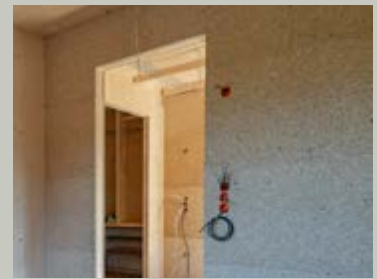
❶ Aufbau in Holzrahmenbauweise, Innenbeplankung der Wände mit esb-Plus Holzbauplatten
