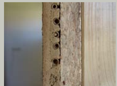
Das Rohrgewebe haftet durch die Klammerung an der esb-Plus Holzbauplatte, der Putzaufbau haftet am Rohrgewebe
